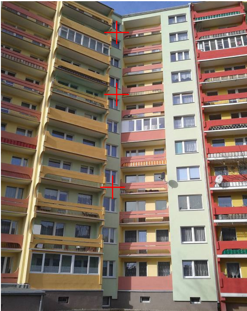
ul. Blankowa 11-13 Wałbrzych Elewacja wschodnia (13) i południowa (11)
