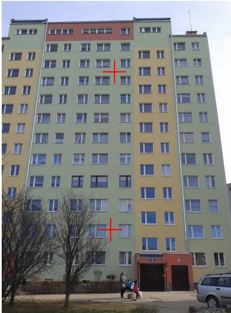
ul. Blankowa 19 Wałbrzych Elewacja zachodnia
